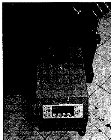
Slika 4. Gorionik za pelet, tip Bergen UNICUS 40 , koji se koristi u kombinaciji sa kotlom na čvrsto gorivo
